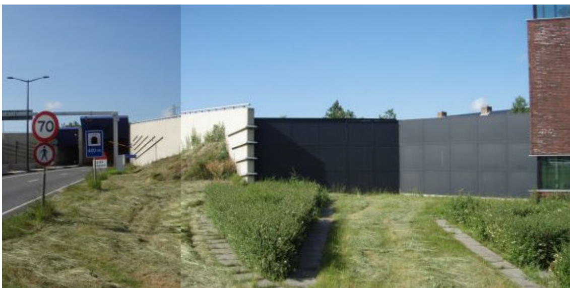
Stalen deur (donker) tussen betonwand tunnelmond (licht) en politiebureau (uiterst rechts)
